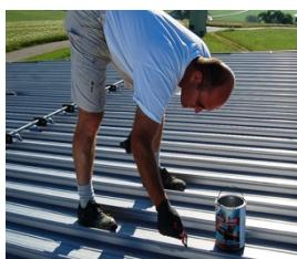
Die Reparaturstellen sind mittels Pinsel oder Rolle 3-4 mal zu streichen (mind. 160 µm Trockenfilmschichtstärke).
