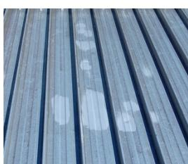
Die Reparaturarbeiten sind so auszuführen, dass die Umgebung der Schadstellen mitbeschichtet wird.
