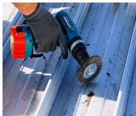
Die Schadstellen sind mechanisch mittels rotierender Drahtbürste metallisch blank aufzubereiten.
